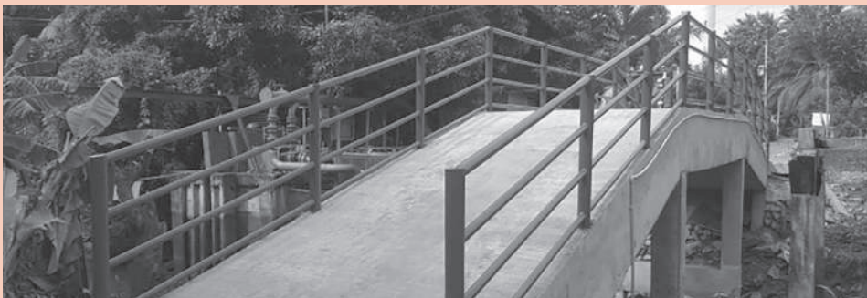
ภาพสะพานที่ดำเนินการก่อสร้างใหม่
